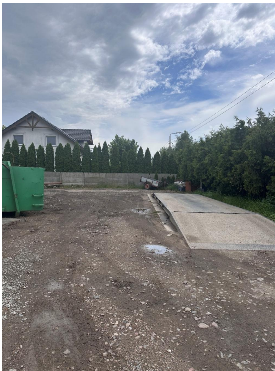
ZDJĘCIE 4: WIDOK OD STRONY PÓŁNOCNEJ, PO PRAWEJ WAGA SAMOCHODOWA
