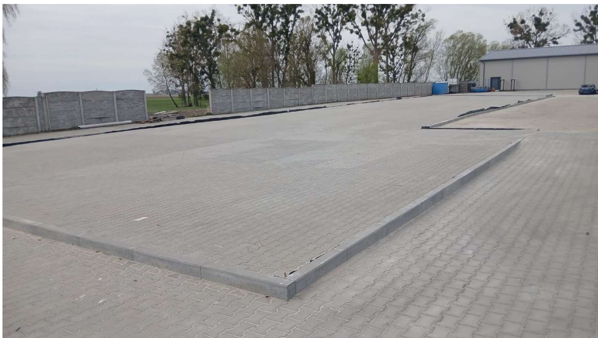
Zdjęcie 2: widok na plac magazynowy do odpadów. przy krawężniku pozostała wyciągnięta folia geomembrana służąca do uszczelnienia placu.
